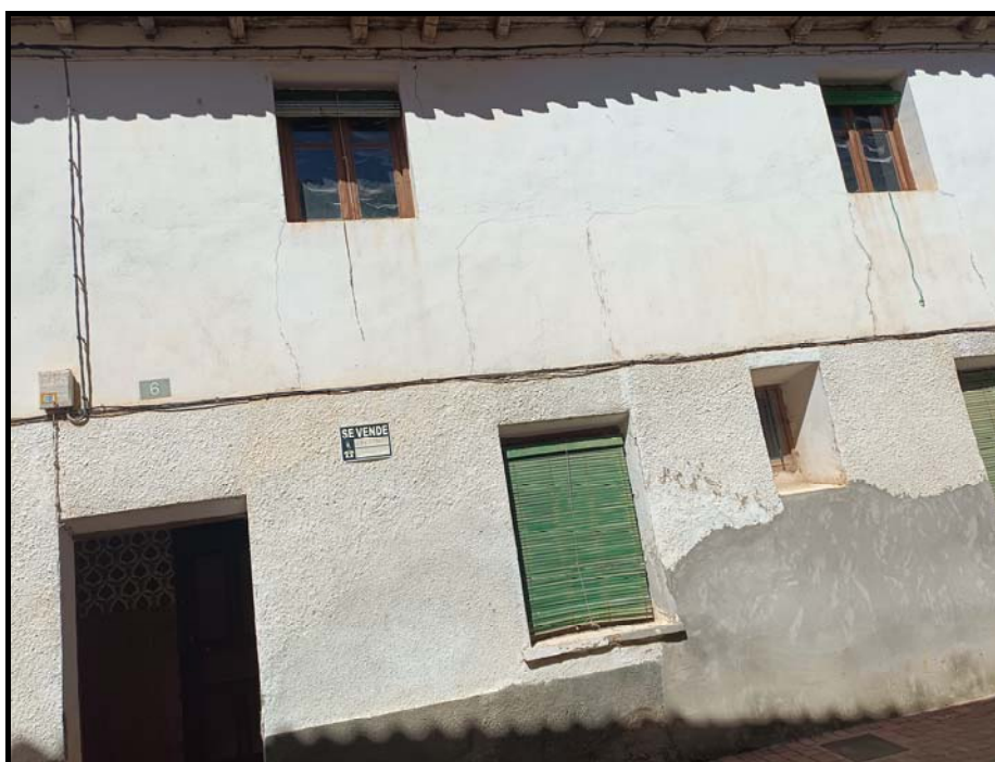
Fotografías fachadas exteriores
