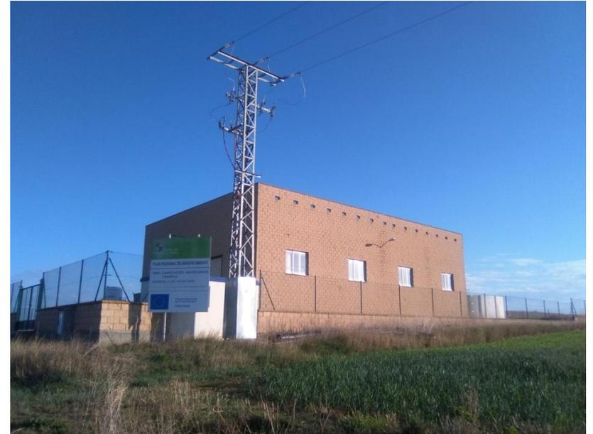
El ciclo del agua de consumo en nuestro municipio consiste en: captación desde el Canal de Castilla, potabilizar en esta potabilizadora, transportar mediante bombas, almacenar en los depósitos, volver a transportar hasta punto de uso, recoger desde punto de uso, transportar, depurar en el caso de Amayuelas de Abajo y próximamente en San Cebrián de Campos y verter a un arroyo lo más limpia posible.
