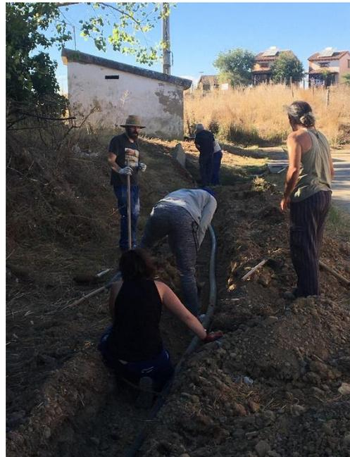
Colocación y enterrado de tubería en zanja entre la fuente y el abrevadero
