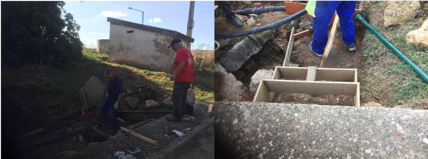
Encofrado de escalones de acceso a la fuente y de pileta para captación del agua
