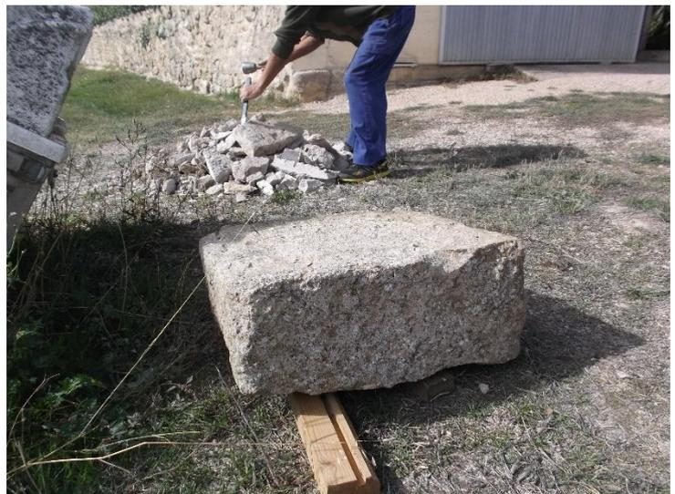
Preparación y labrado de piedras para las paredes del pilón
